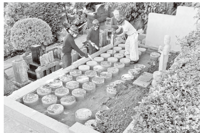
最終段階の骨壺納骨筒の永久固定仕上げ作業（横浜慶弍寺樹木葬墓地）
