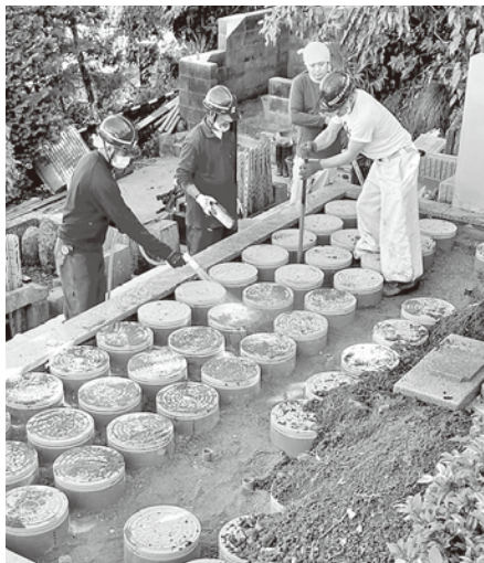
最終段階の骨壺納骨筒の固定仕上げ作業（右）と現在のようす（横浜慶珊寺樹木葬墓地）
